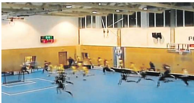
Nehoda Propadlá střecha haly v České Třebové (nahore). Foto: ČTK
