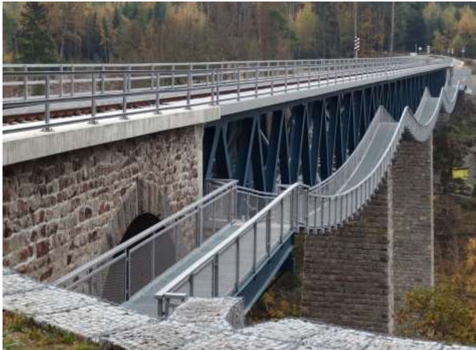
Obr. 3 Rekonstruovaný železniční most s lávkou pro pěší
