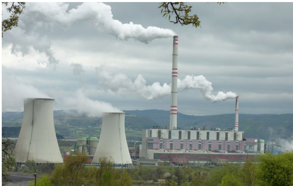
EGP INVEST, spol. s r.o. se podílí na rekonstrukci elektrárny Prunéřov II.
