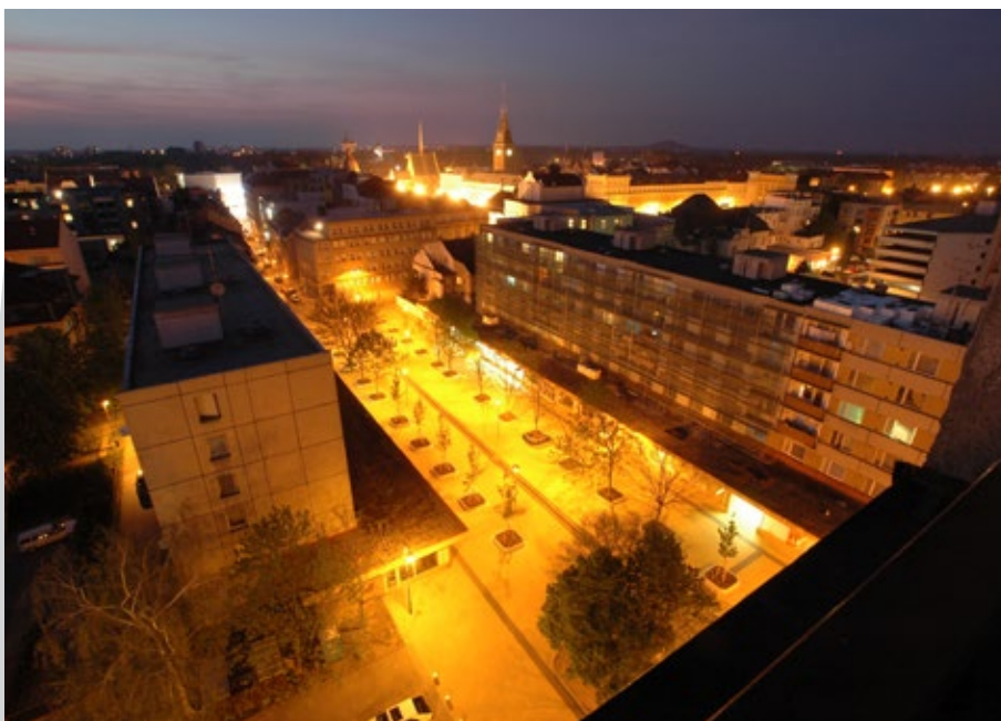
Stavební úpravy ulice Jiřího z Poděbrad v Pardubicích Realizátor: Enteria a.s.
