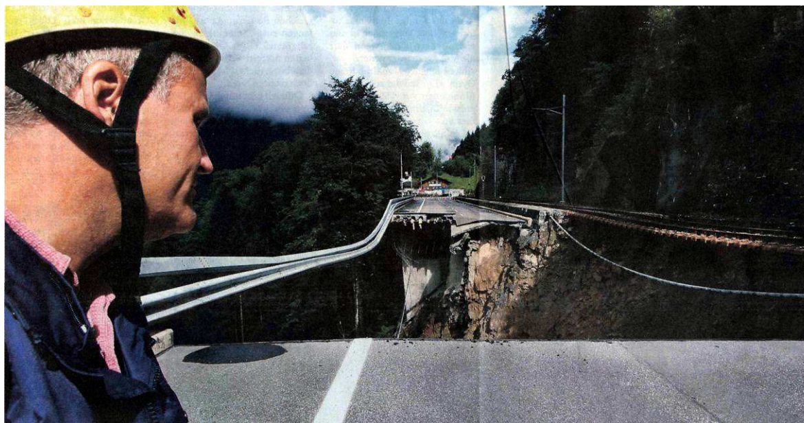
Porucha mostní konstrukcí v důsledku sesuvu blízkého svahu
