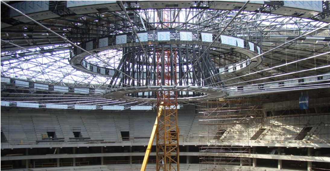
Obr. 11. Konstrukce po odstranění provizorní podpory a po instalaci kruhových mostů
