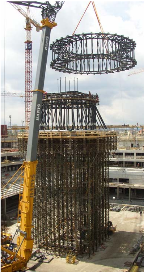
Obr. 4. Montáž horní části tubusu
