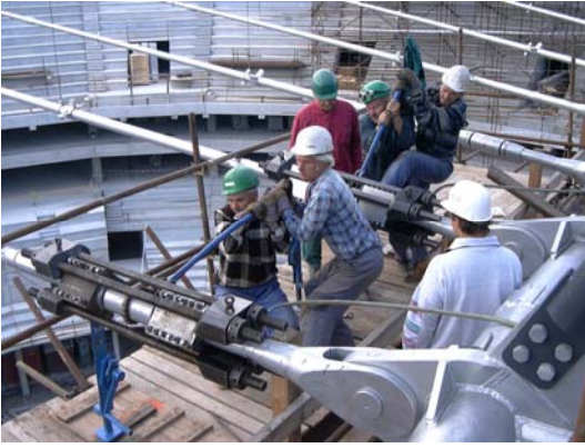
Obr. 9. Předpínání táhel s použitím hydraulického zařízení
