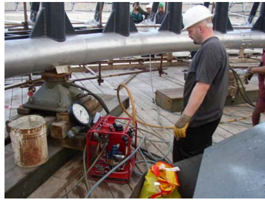
Obr. 10. Hydraulické zařízení pro předpínání a jeden z 12 zvedáků na kterých byl tubus uložen
