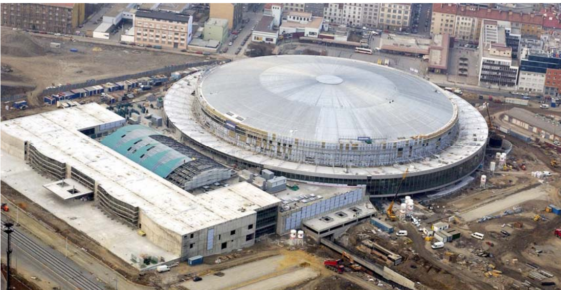
Obr. 12. Sazka Arena po instalaci střešních panelů
