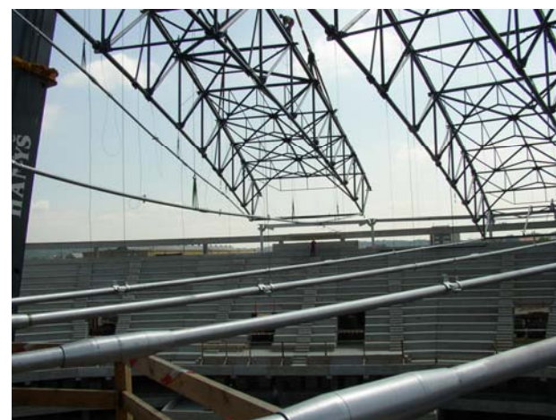
Obr. 5. Konstrukce po dokončení 1/4 vazníků Obr. 6. Montáž dvojice vazníků a táhel
