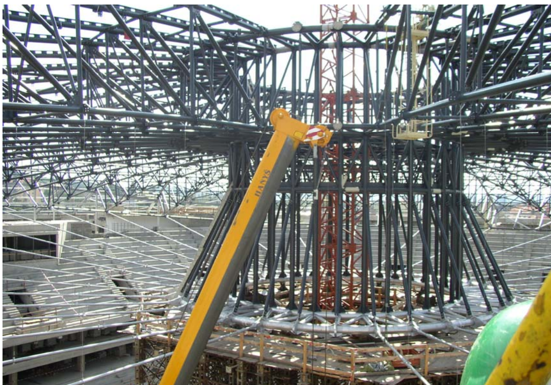
Obr. 7. Styk vazníků a táhel s centrálním tubusem
