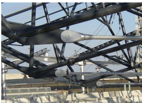
Obr. 13. – 17. Konstrukční detail připojení táhla k vazníku a k tubusu.
