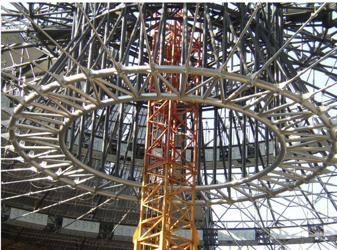
Obr.18. Spodní prstenec tubusu a táhla
