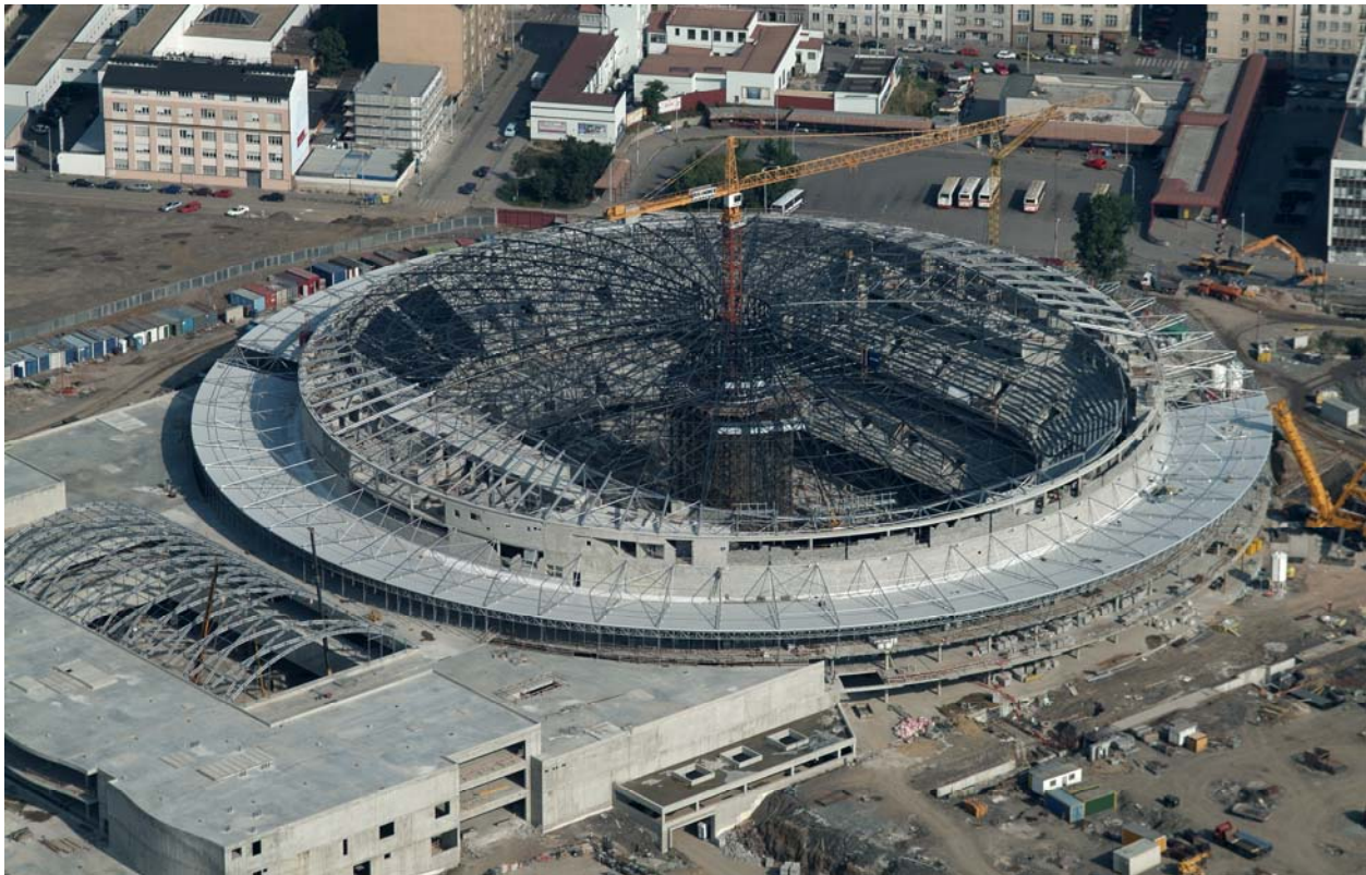
Obr.1. Arena Sazka, letecký pohled při montáži
