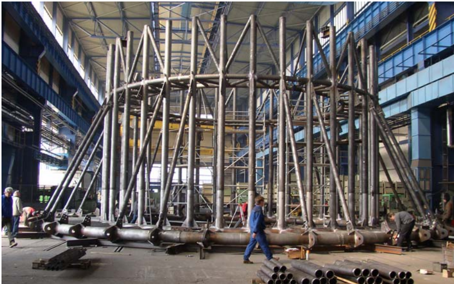
Obr. 3. Předmontáž spodní části tubusu
