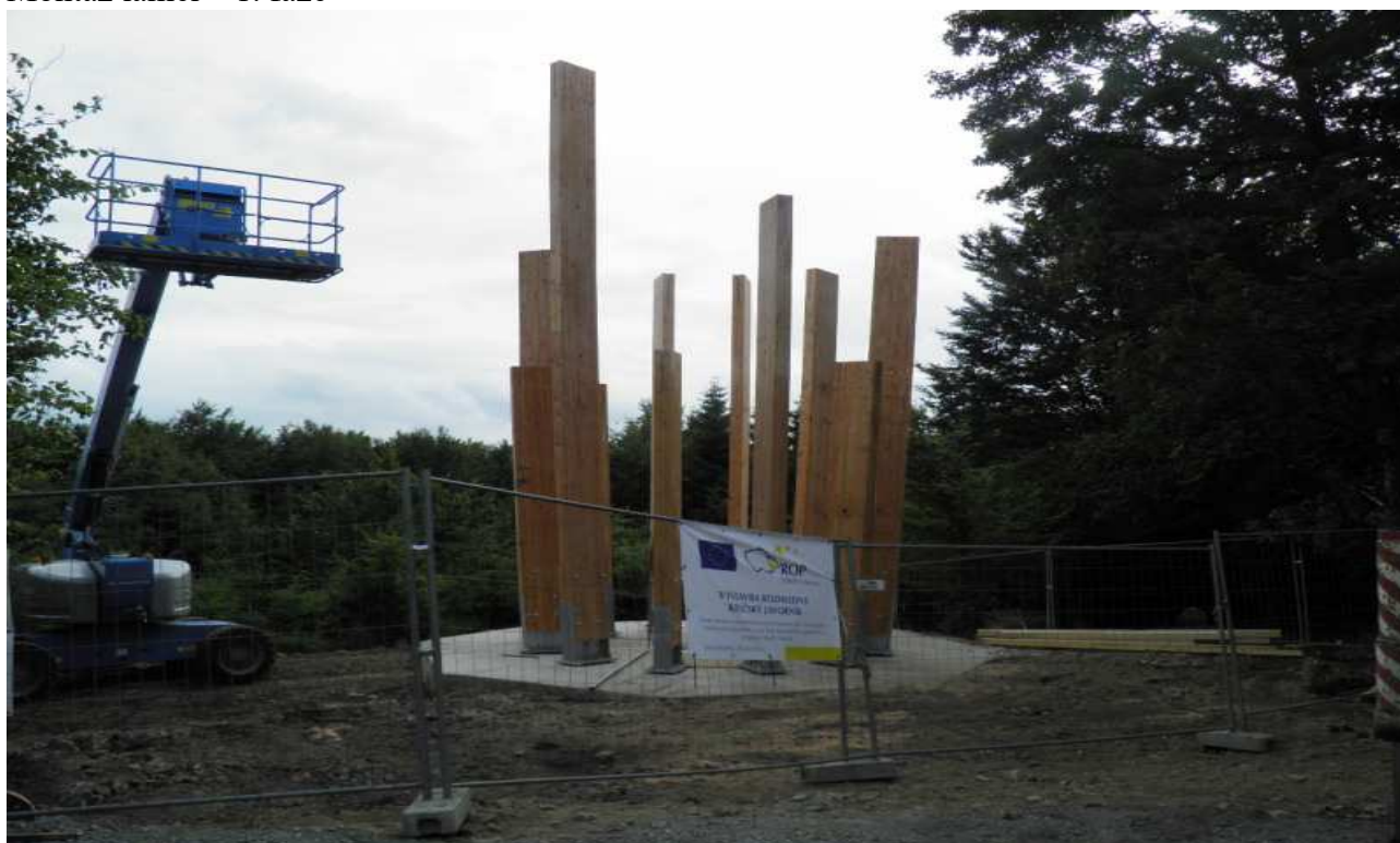
Montáž lamel – 1. fáze
