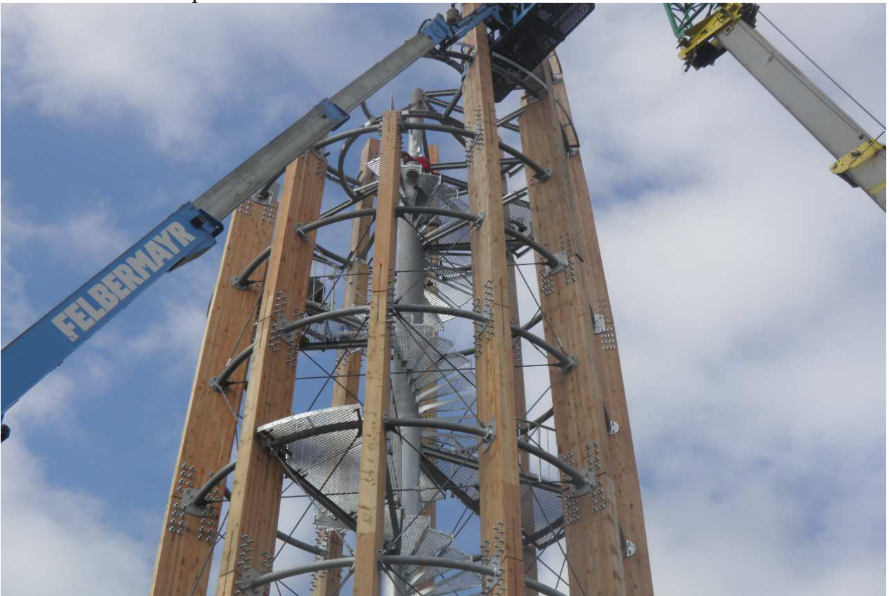
Detail – montáž nástupů
