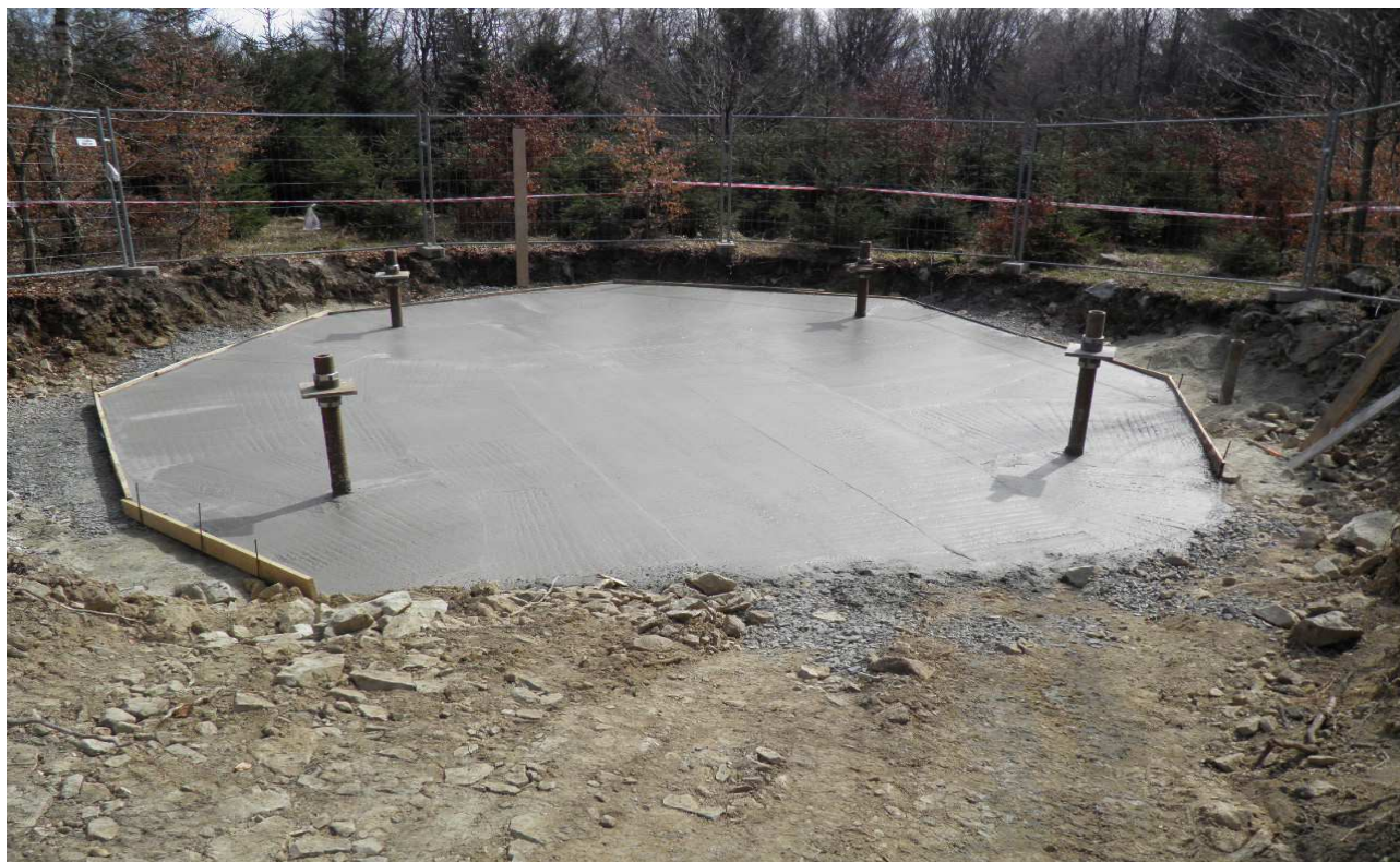
Podkladový beton
