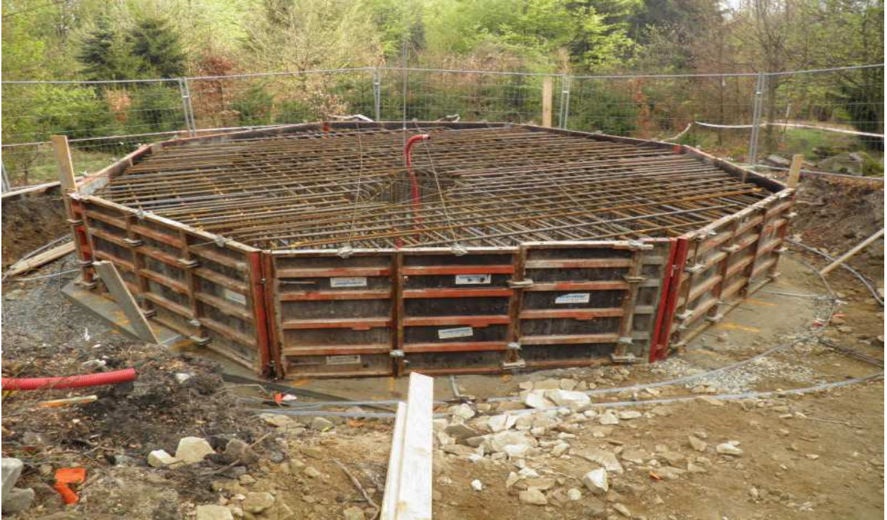
Bednění před betonáží
