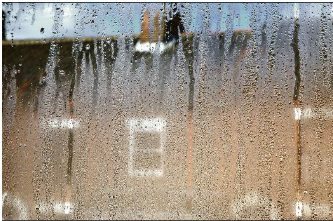
Neodvětraná vlhkost způsobuje v zatepleném objektu růst plísní.
