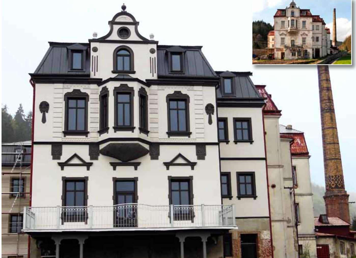
01 > Jižní část fasády před a po rekonstrukci
