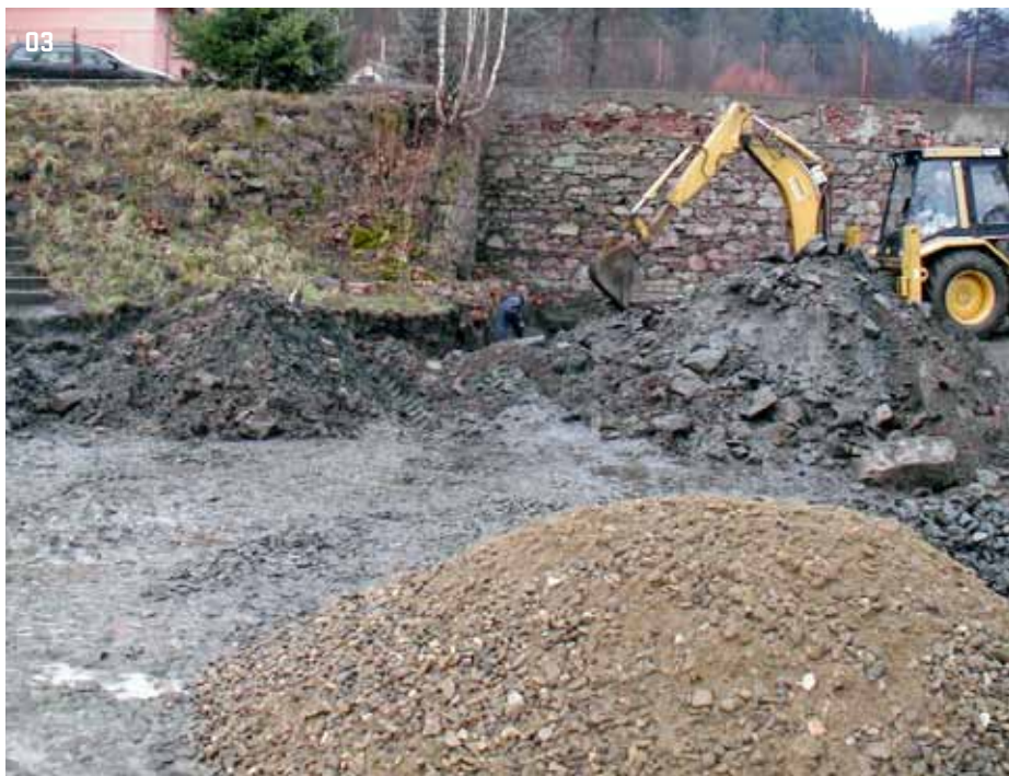
03 > Postupné zřizování betonového základu opěrné zdi terasy
