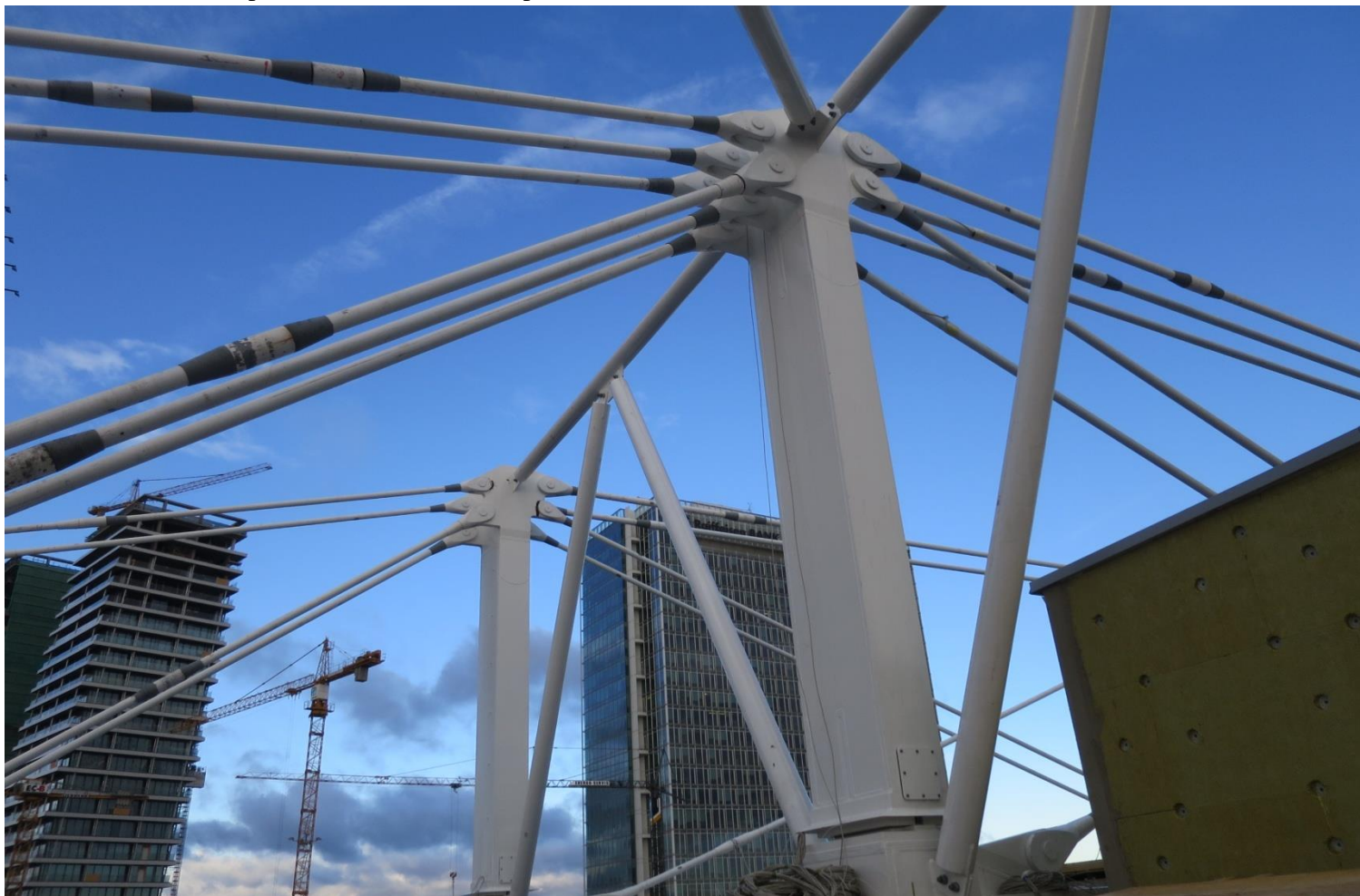
Předpínaná nosná konstrukce budovy Trimaran, Praha 4 - Pankrác
