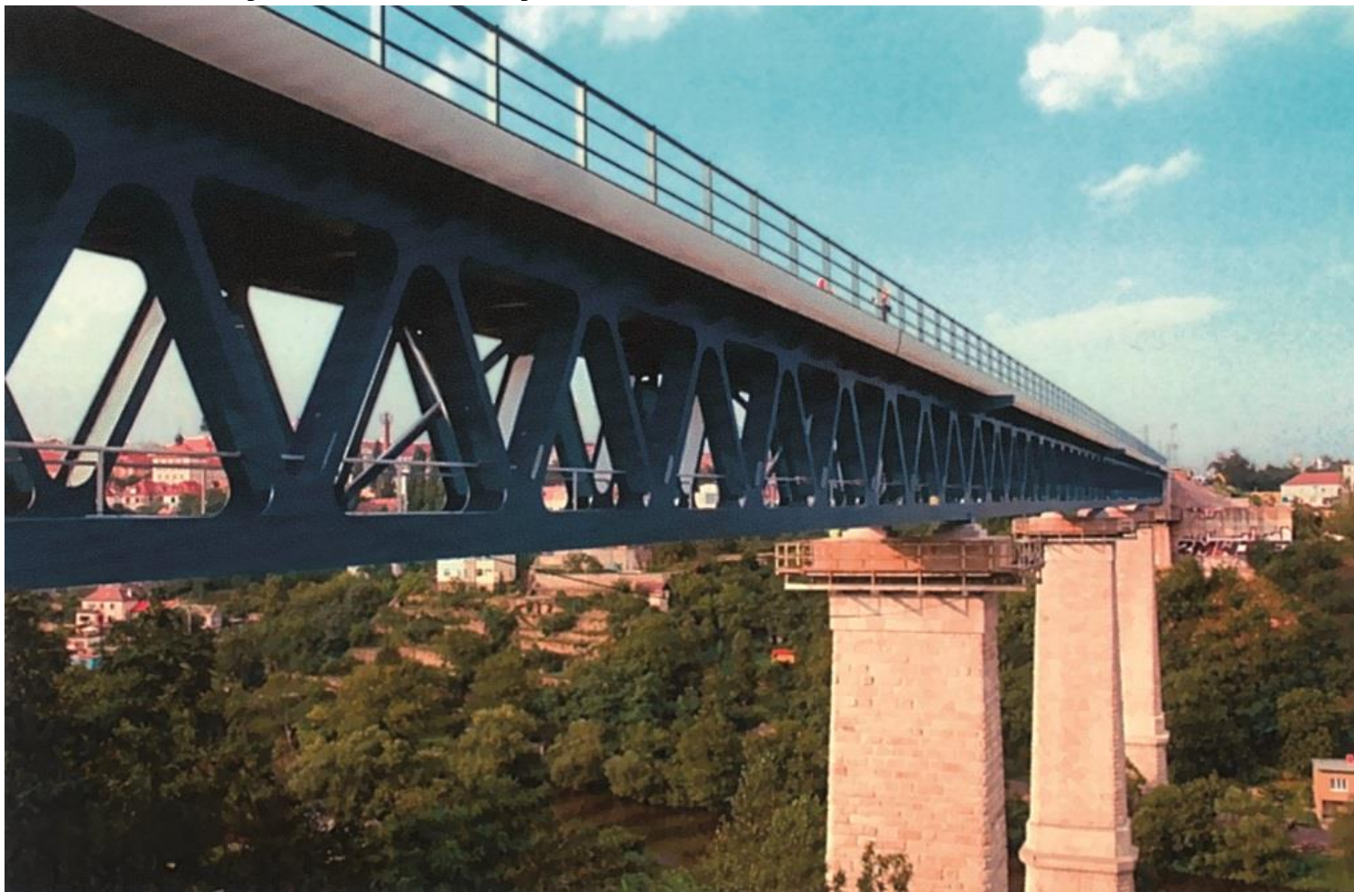
Rekonstrukce Znojemskeho viaduktu
