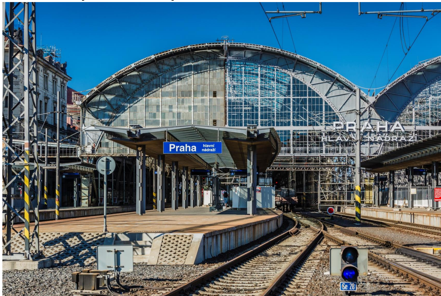
Rekonstrukce ocelové konstrukce historické haly zastřešení nástupišť na Hlavním nádraží v Praze
