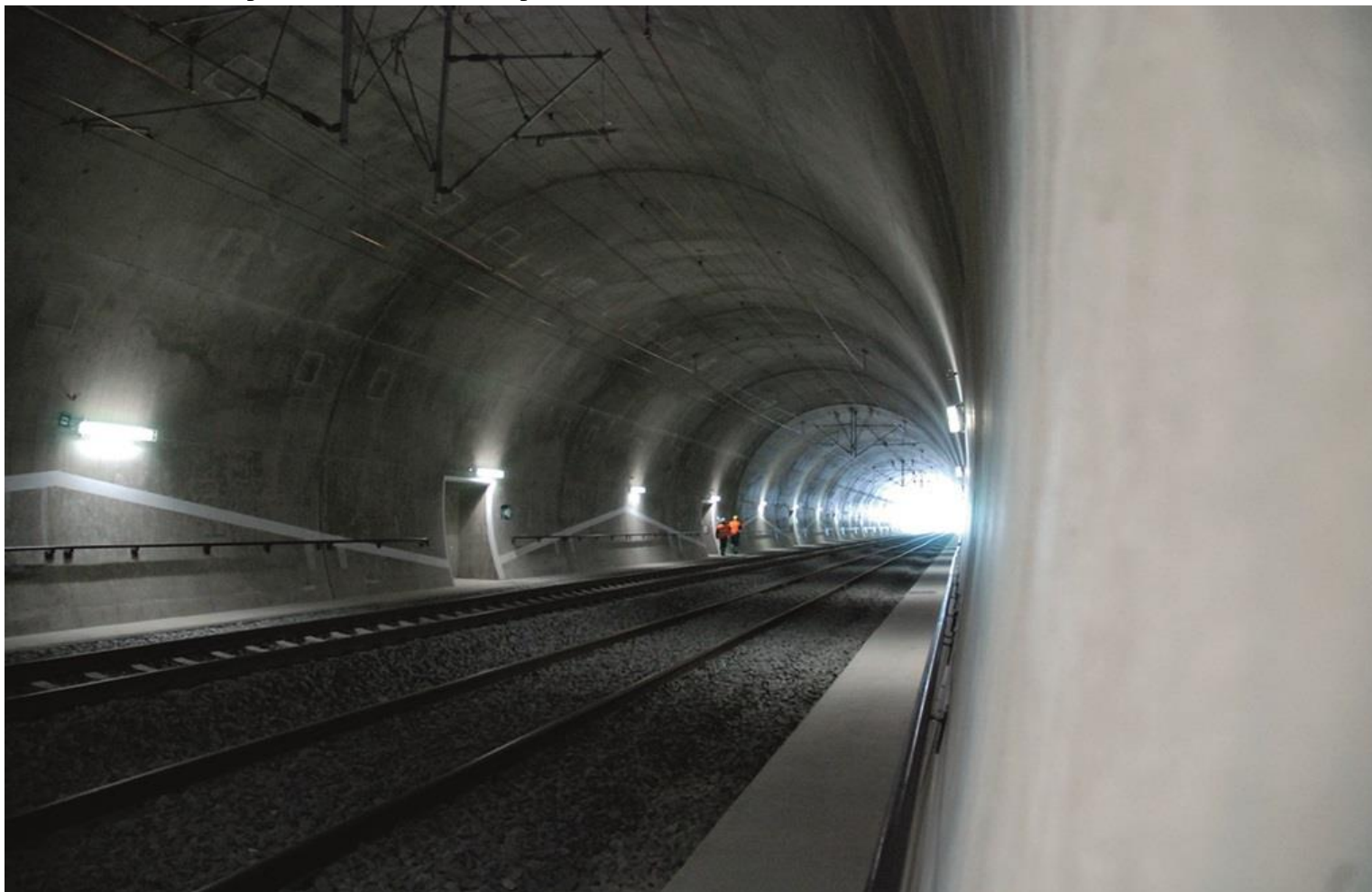
Tunel Jablunkovský II. – Zmáhání závalu
