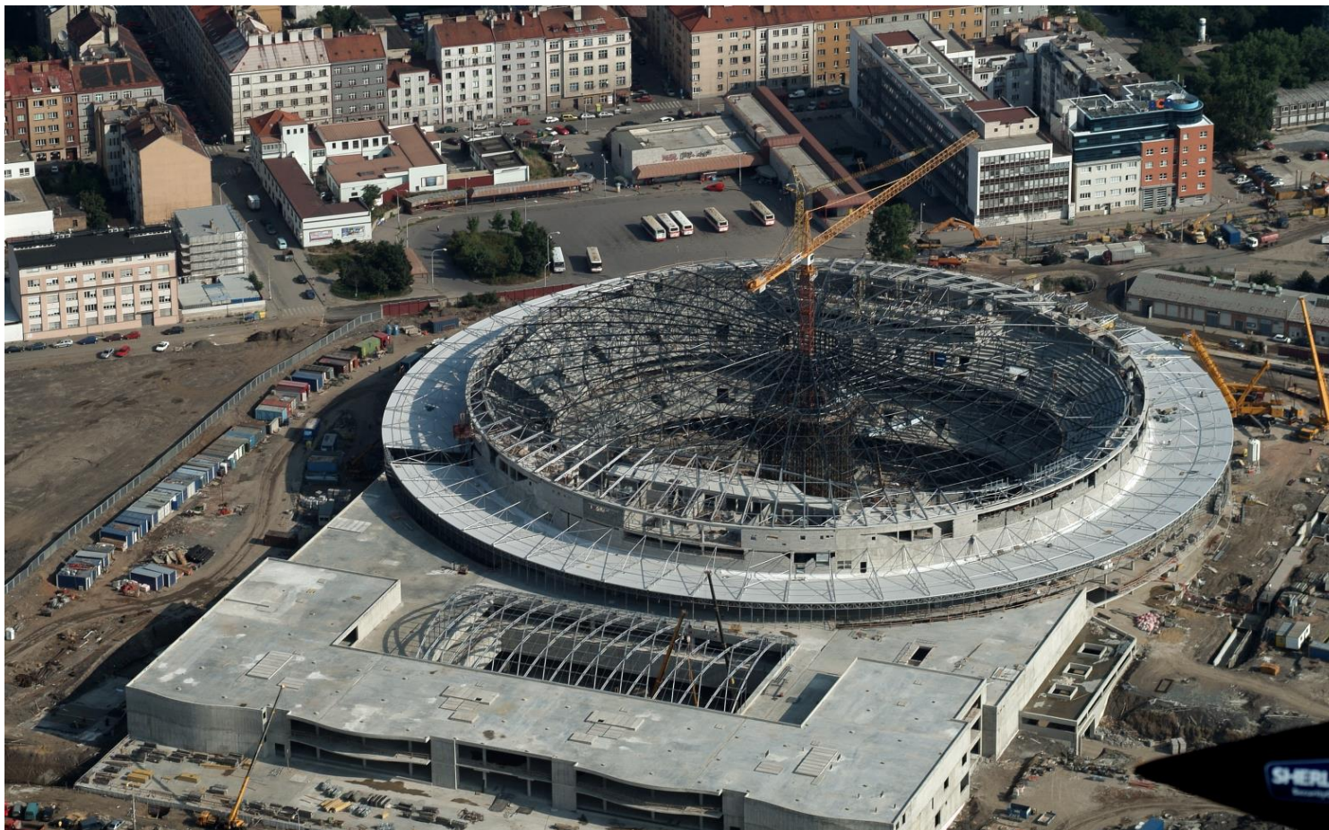
Sazka Aréna – Ocelová konstrukce ve výstavbě Ing. Vladimír Janata, CSc., EXCON, a.s., Praha
