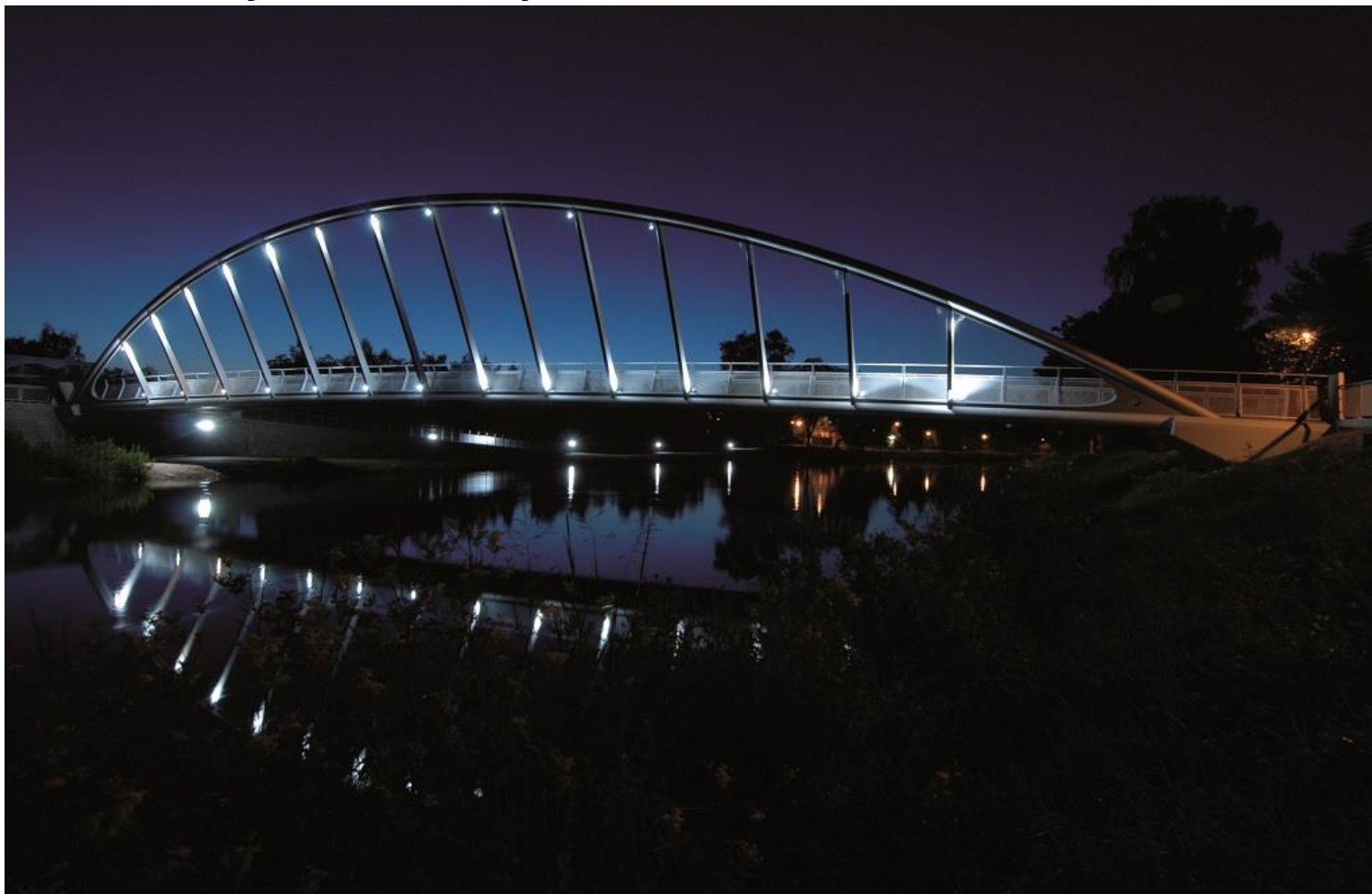
Lávka přes řeku Vltavu v Českých Budějovicích
