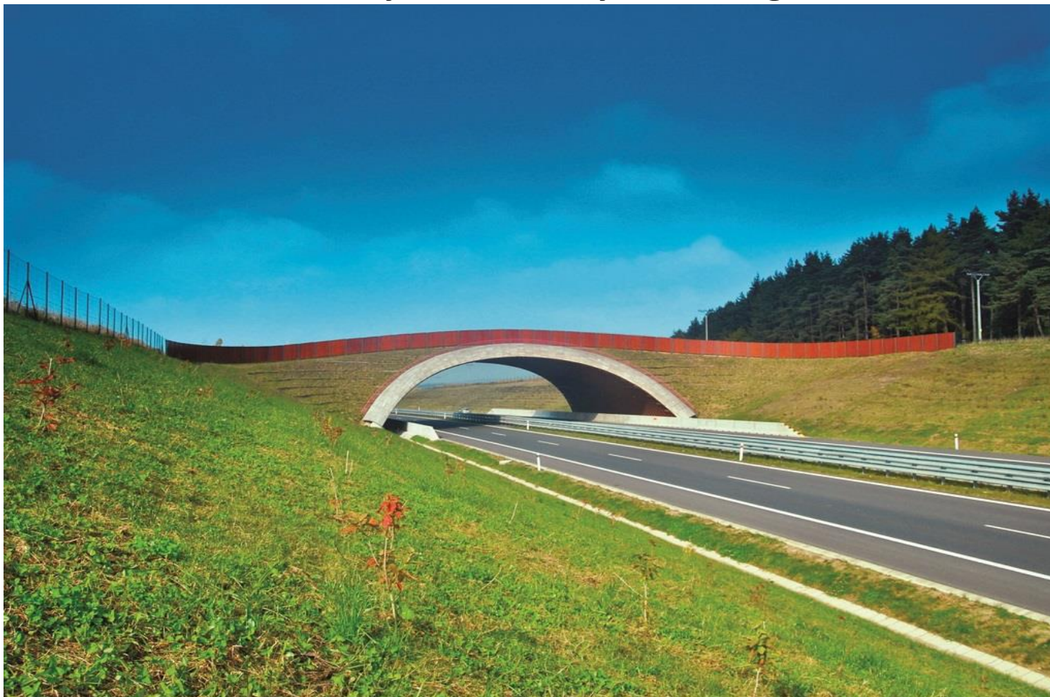
Ekodukt s aplikací obloukových lepených lamelových dřevěných nosníků na stavbě dálnice D1 Mengusovce – Jánovce, III. etapa, objekt C 231 Ing. Vladimír Brejcha, FEng., Ing. Rastislav Kan, Ing. Roman Lenner, Ing. Jiří Jachan, SMP CZ, a.s., Praha
