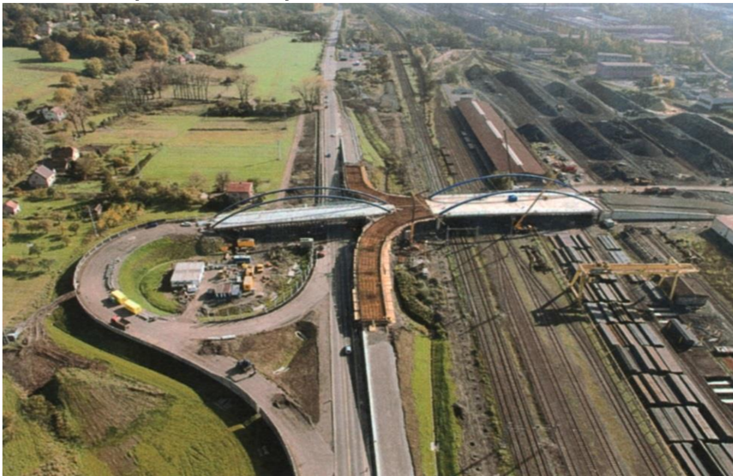
Mosty na mimoúrovňovém propojení silnice II/468 a průmyslové zóny v Třinci - Balinách
