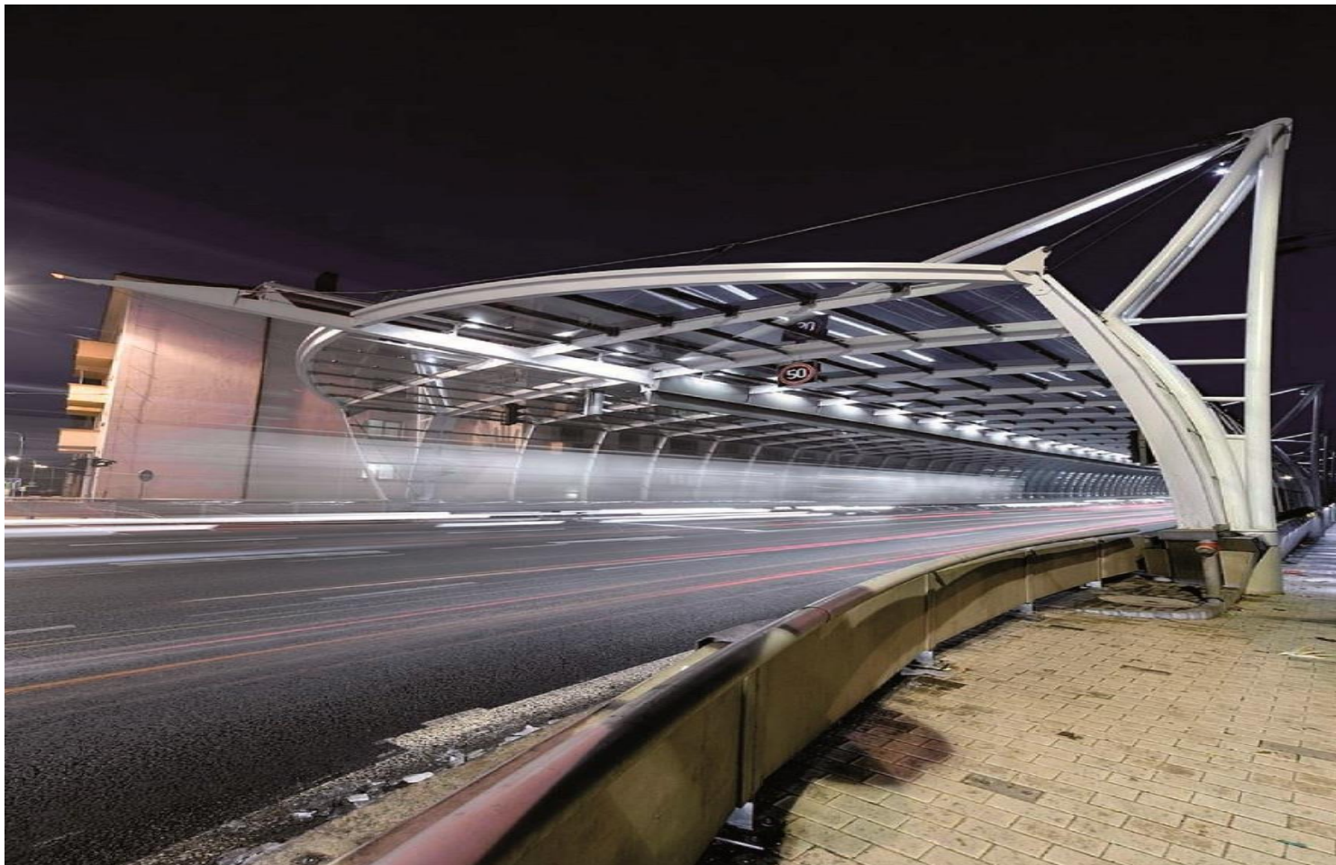
Nosná ocelová konstrukce protihlukového tunelu Hradec Králové Ing. Vladimír Janata, CSc., Ing. Jiří Lahodný, EXCON, a.s., Praha
