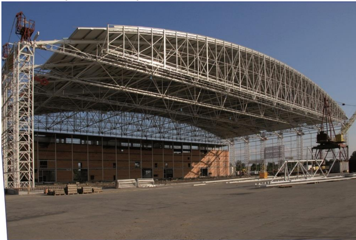
Nosná ocelová konstrukce hangáru Mošnov Ing. Vladimír Janata, CSc., EXCON, a.s., Praha
