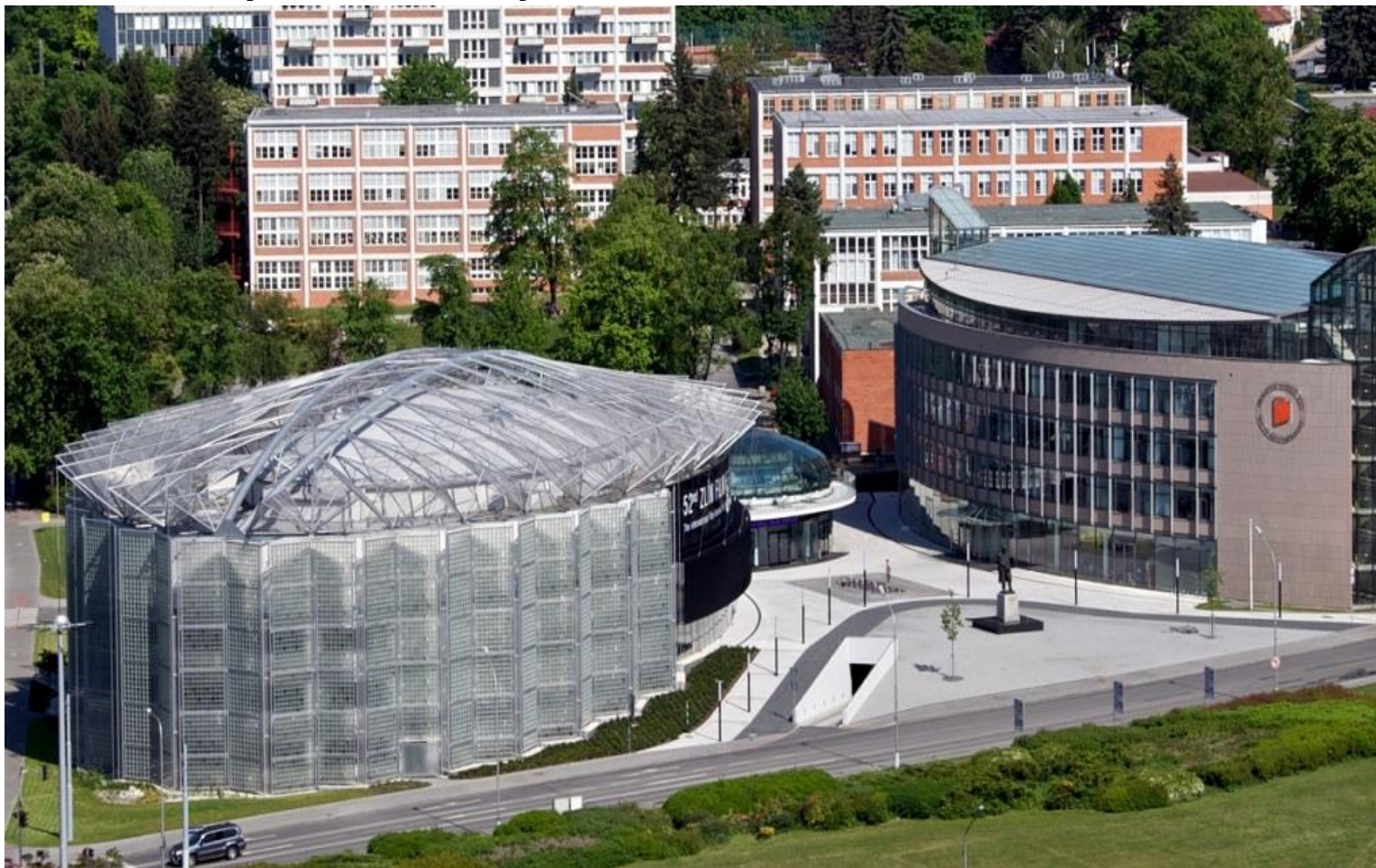
Kongresové centrum Zlín – ocelové konstrukce střešního „diatomu“, skleněného pláště a restaurace Ing. Vladimír Ferkl, Zdeněk Doležal, Ing. arch. Eva Jiříčná, SKÁLA&VÍT, s.r.o., Hradec Králové
