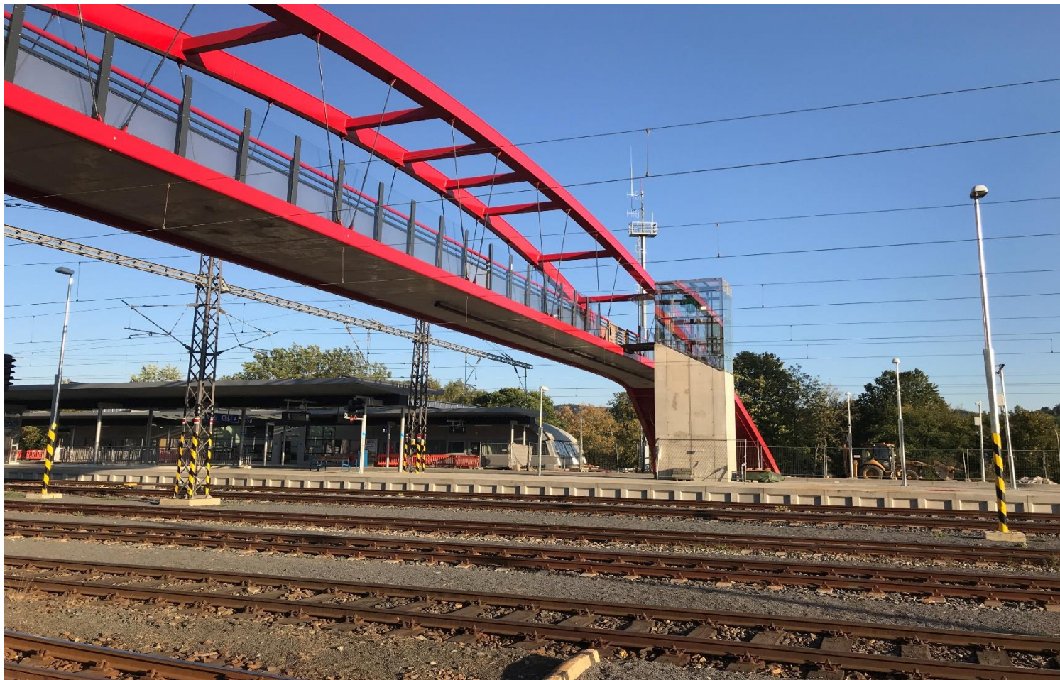
Lávka přes Horní nádraží v Karlových Varech
