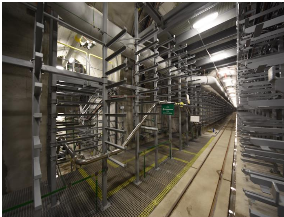
Obr. 3 Detail ze Stavby č. 8615 „Kolektor Hlávkův most“
