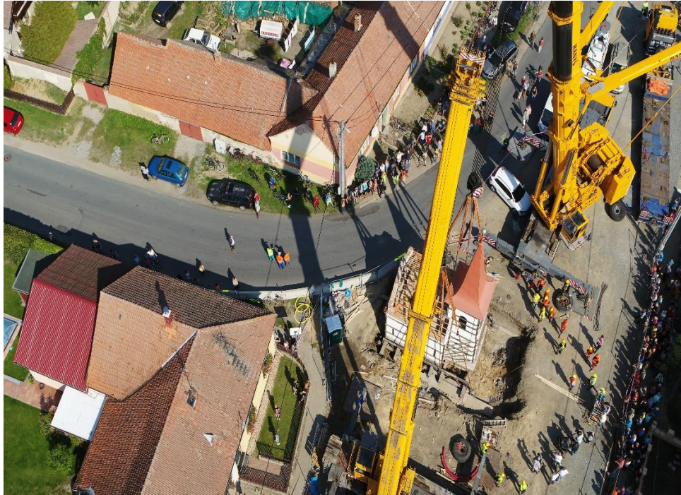
Obr. 4 Letecký pohled na přesun kaple sv. Jana Nepomuckého a Panny Marie v Ivančicích-Letkovicích
