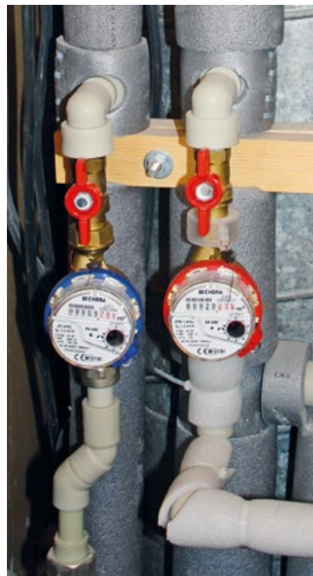
Bytové vodoměry v instalační šachtě
