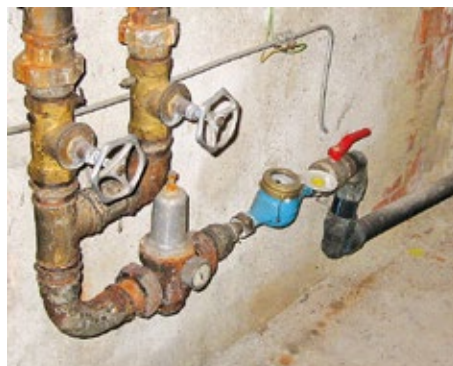
Příklad umístění fakturačního vodoměru ve sklepě
