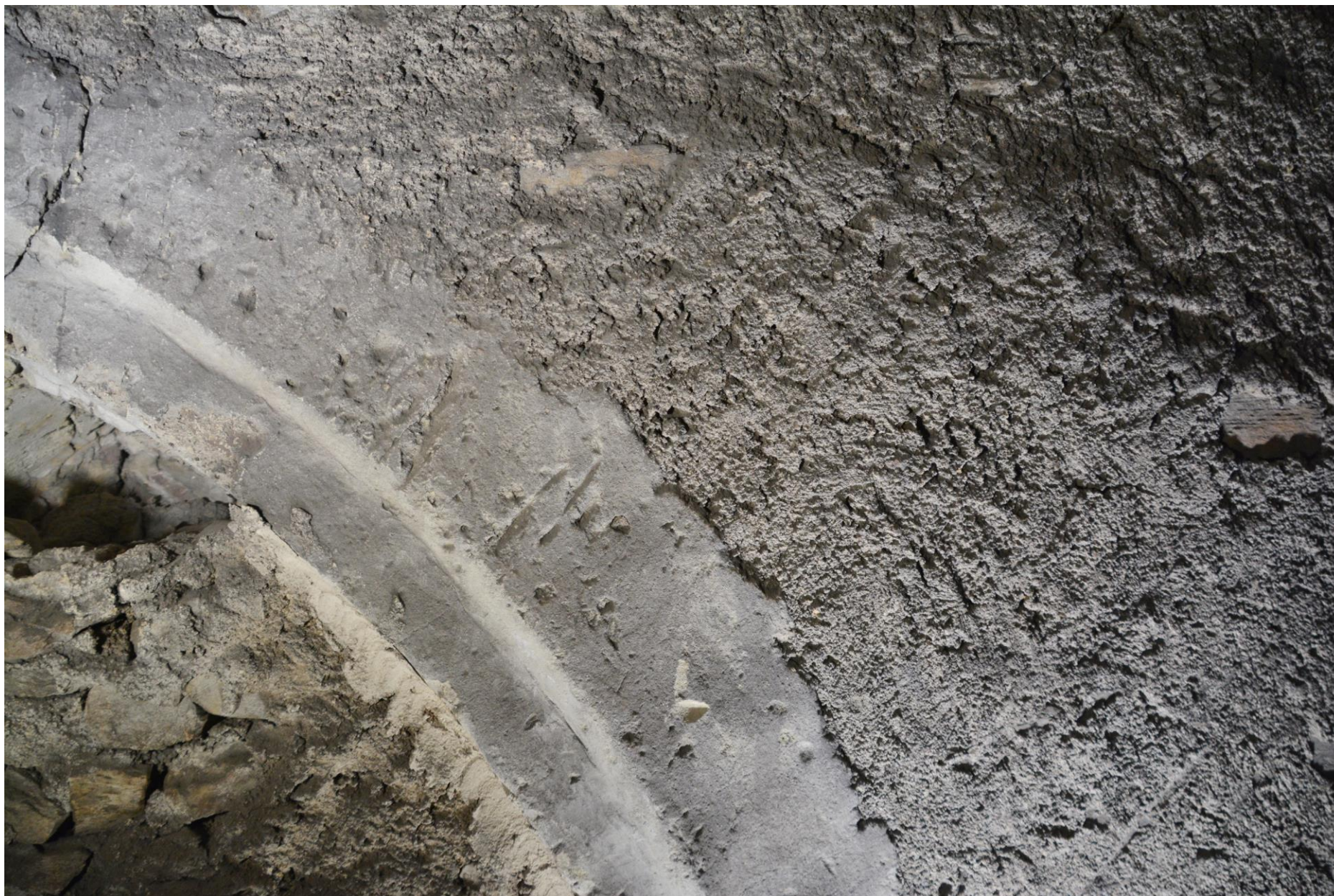
Polodetail hlazené pasparty lomeného okna a hrubé omítky základních ploch s odlišným nasvícením.
