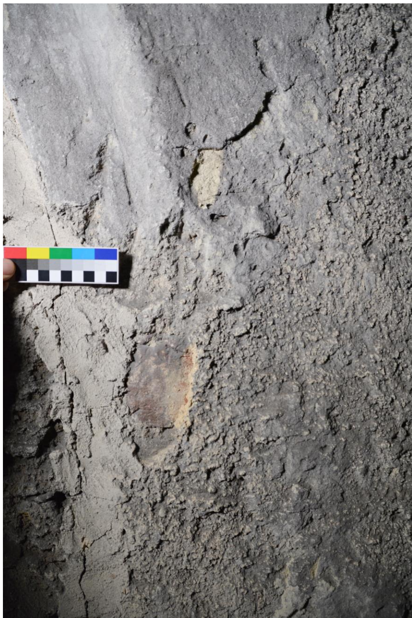
Polodetail zachycující místa odběru vzorků malt jemné omítky okenní pasparty (nahore) a hrubé omítky základních ploch (dole).
