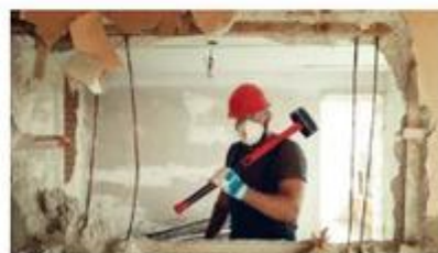
Problematika odstranění stavby
