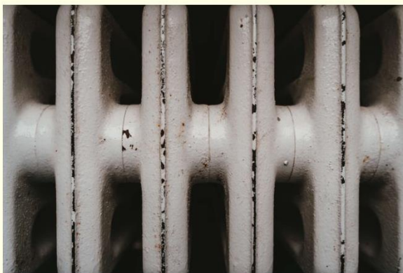
Klasický radiátor je pro tepelné čerpadlo nevhodný. Foto: Photo by Julian Hochgesang na Unsplash
