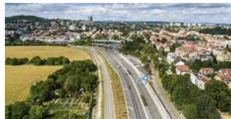
5. I/42 Brno, VMO Žabovřeská I Přihlašovatel: Ing. David Berger, hlavní inženýr projektu, oblast Brno
