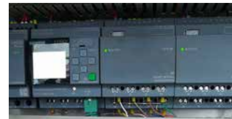
7. Obnova elektroinstalace bytových domů MČ Brno-Vinohrady, 3. etapa Přihlašovatel: Bc. Martin Olbrecht, projektant, oblast Brno
