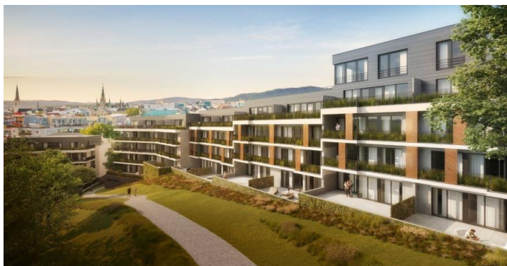
Pohled na vizualizaci části zástavby, která je v současné době ve výstavbě.
