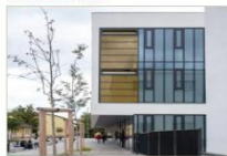
Přístavba ZŠ v Čakovicích
