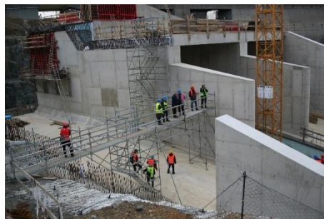
Nátokový objekt přelivu
