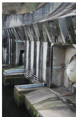
Stávající přeliv s výtoky od turbín
