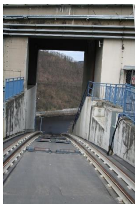
Průchod hrází pro výtah MP
