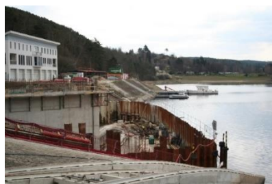
Založení horního nátokového objektu
