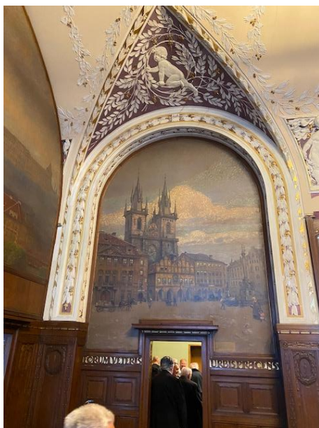
Část vládního salonku v jižním křídle, které je před rekonstrukcí
